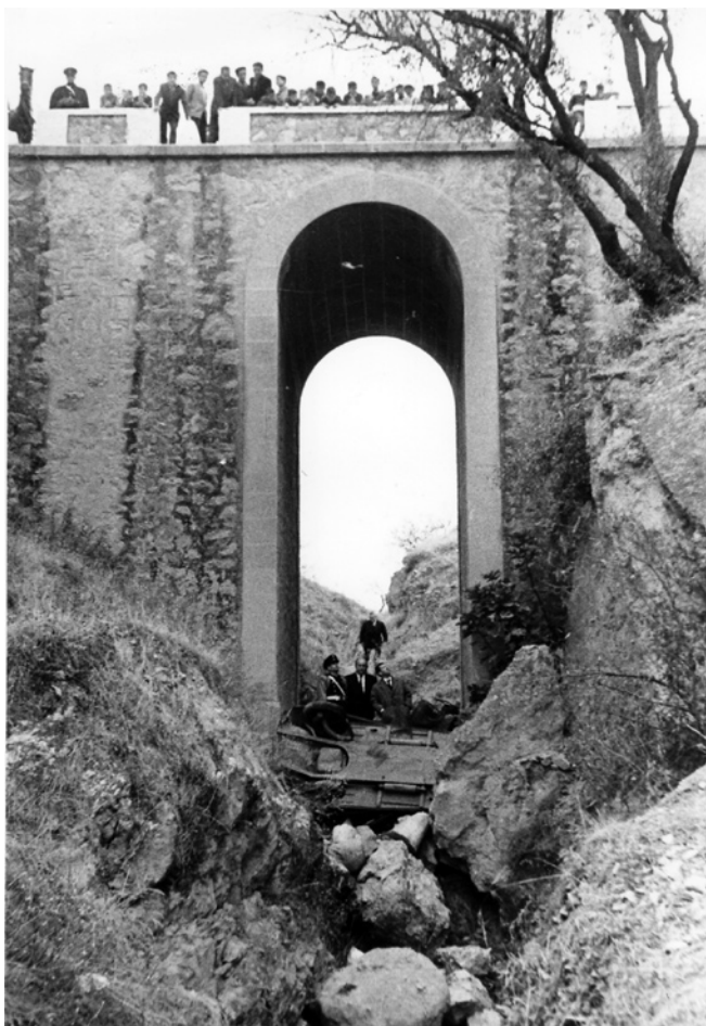
Puente en la desviación hacia el Neveral en la Carretera de Circunvalación
