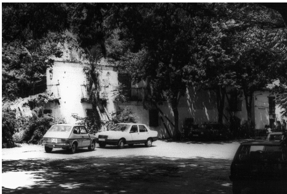
Casas de Jabalcuz, 1,2,3,4, ya en ruinas
