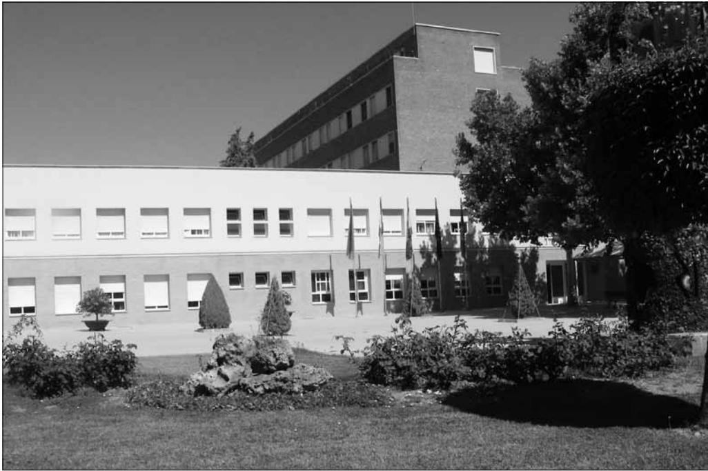
Edificio B1. Rectorado
