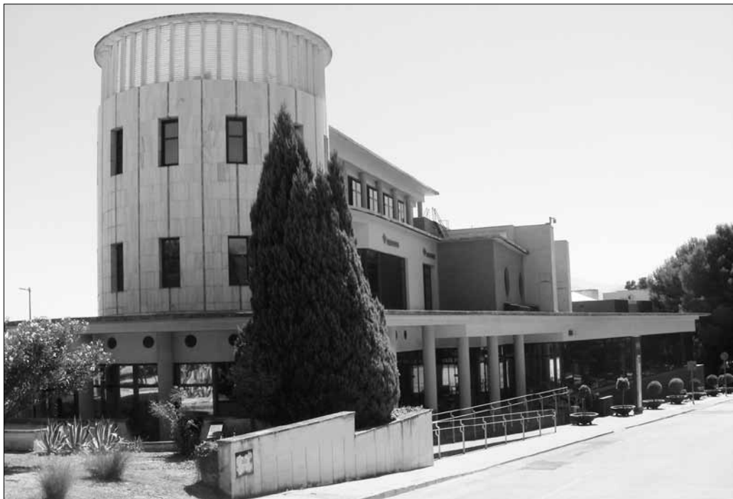
Edificio D1. Zabaleta
