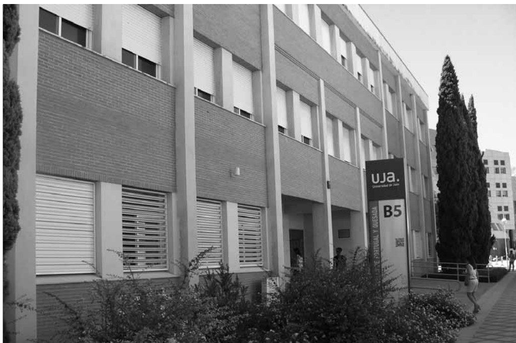
Edificio B5. Aulario Coello de Portugal y Quesada
