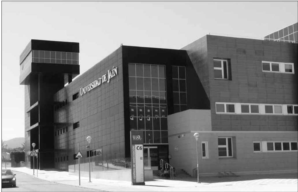
Edificio C6. Centros de Investigación
