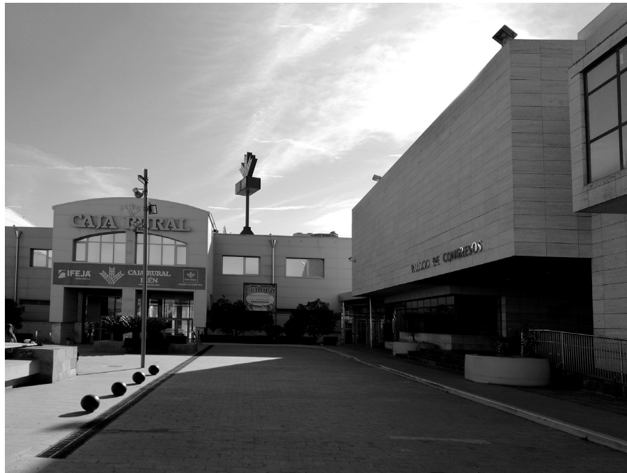
Acceso al vestíbulo del edificio administrativo y salas de conferencias de la IFEJA
