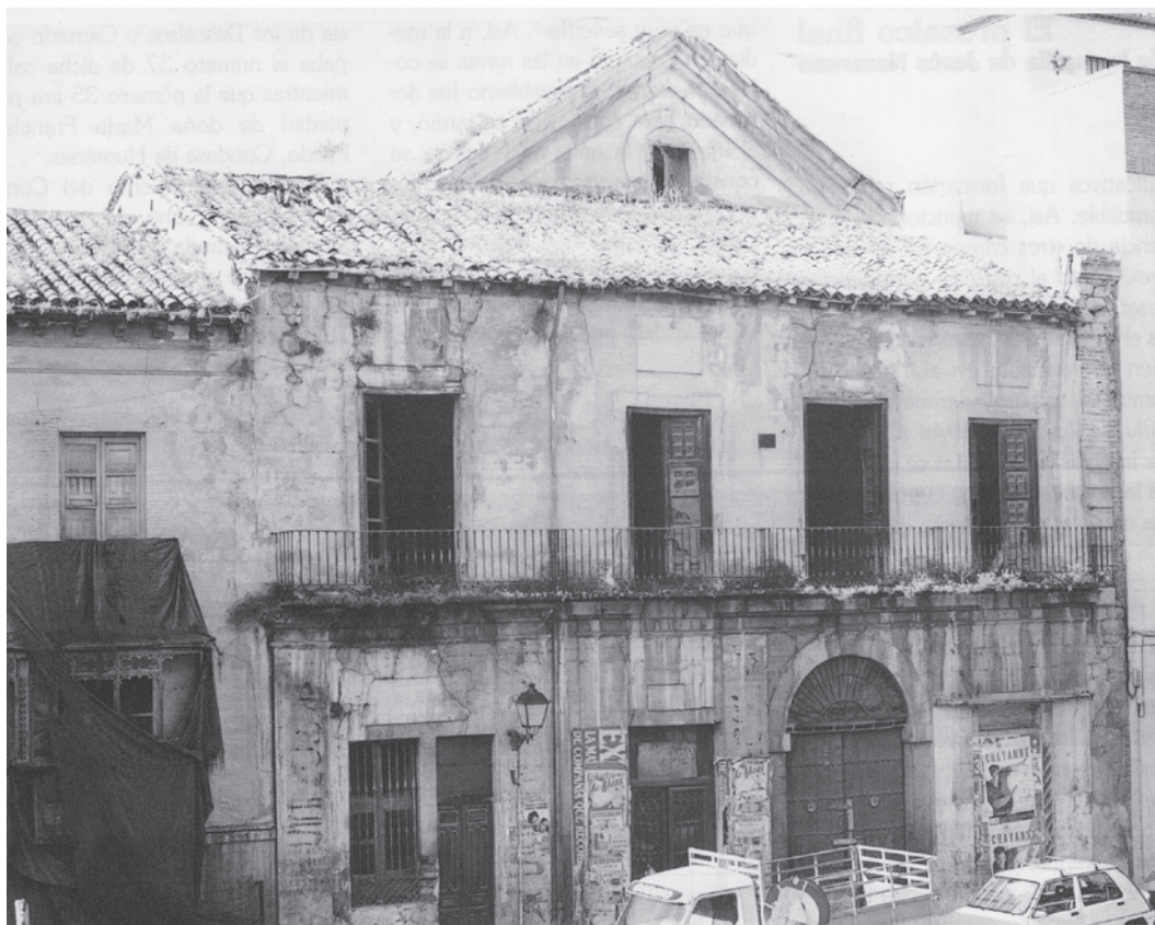
Estado ruinoso en el que se encontraba el Convento de San José de los Descalzos
