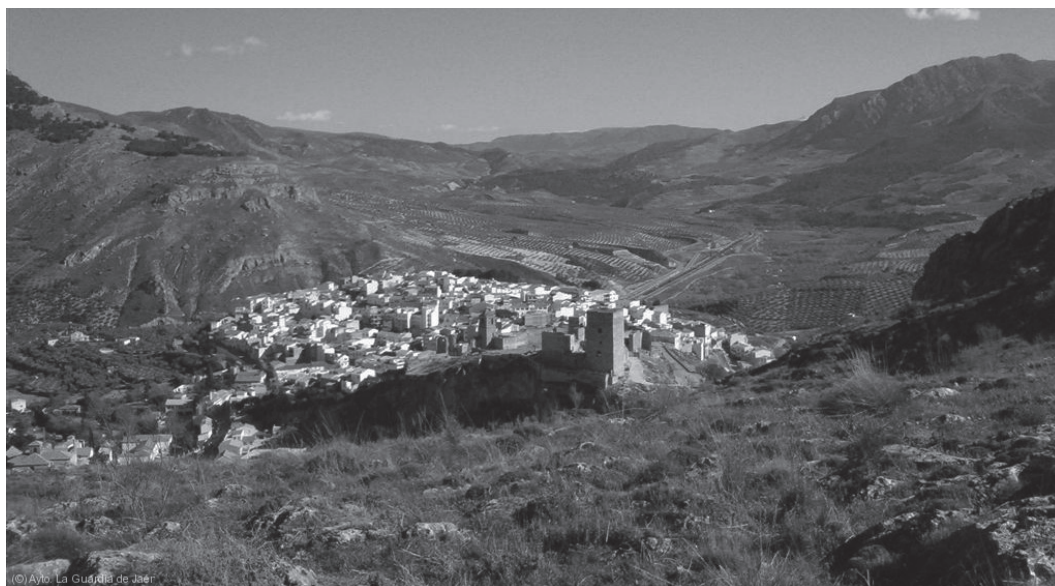
Vista general de la fortificación de La Guardia desde lo alto del cerro de San Cristóbal.
