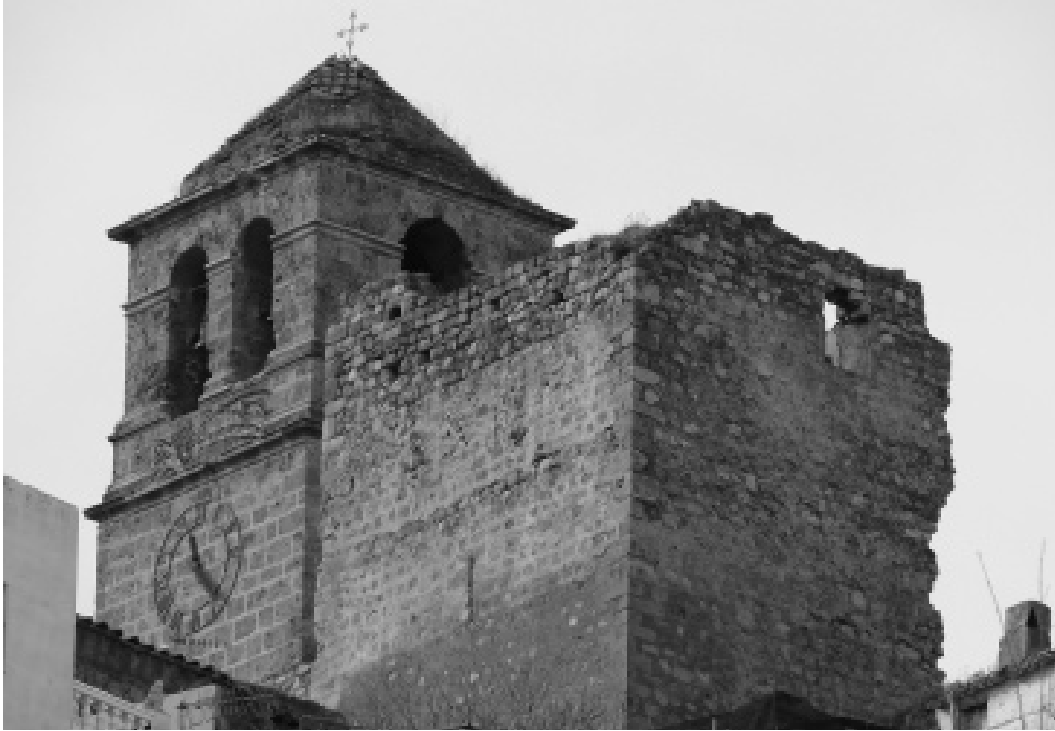
Vista oriental del ábside y torre campanario de la antigua iglesia de Santa María
