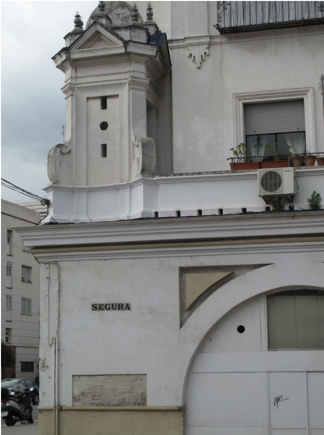
Calle Segura, en las inmediaciones de los antiguos almacenes de madera de Segura, en Sevilla
