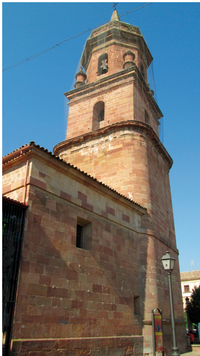
Andújar. San Miguel. Torre campanario y capilla del bautismo
