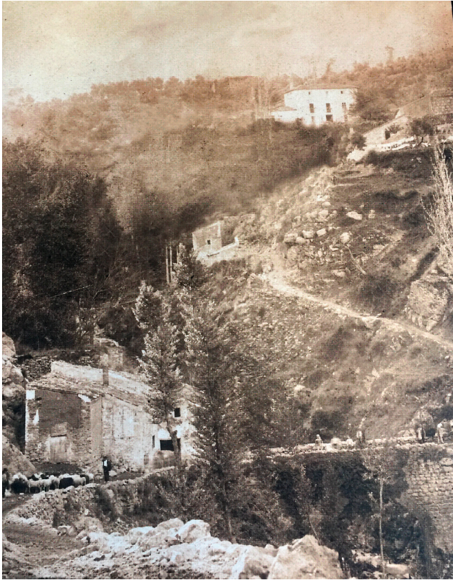
Retrospectiva con la Central «Santo Domingo» a la izquierda y la de «Los Molinos del Marqués» al fondo. Las fábricas de arriba y de abajo como siempre se han llamado en el pueblo. En primer término el puente de Vandelvira
