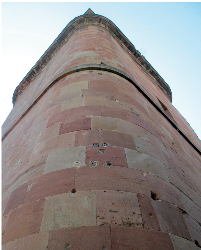
Andújar. San Miguel. Detalle del forro de la torre campanario. Foto del autor
