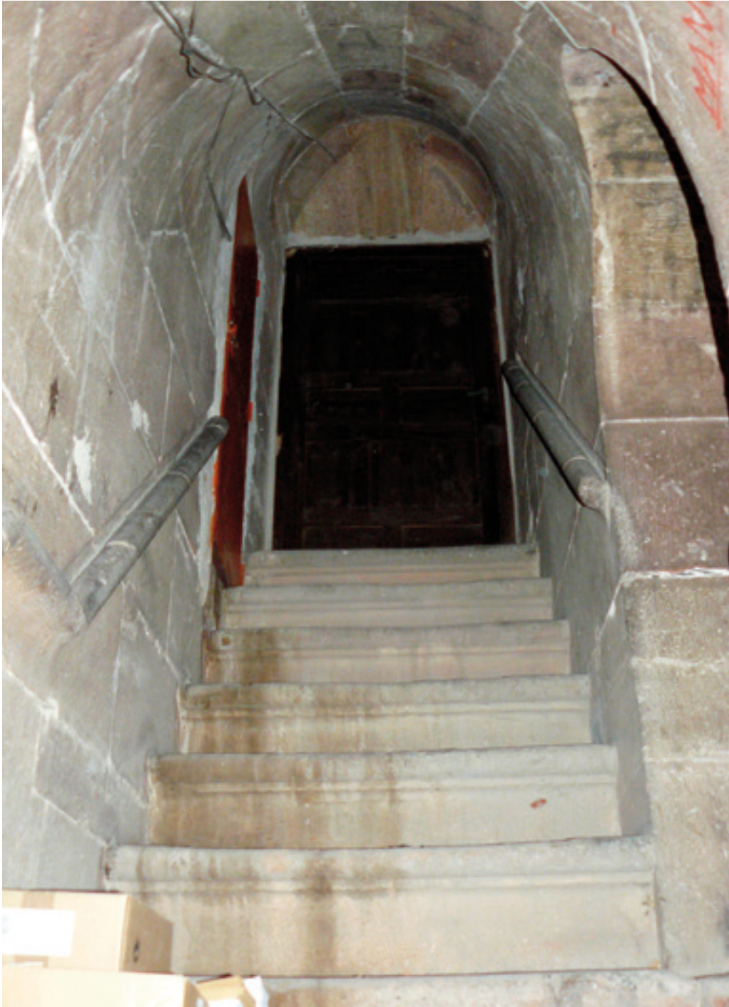
Andújar. San Miguel. Escalera de acceso al interior de la torre campanario, coro y bóvedas. Foto del autor
