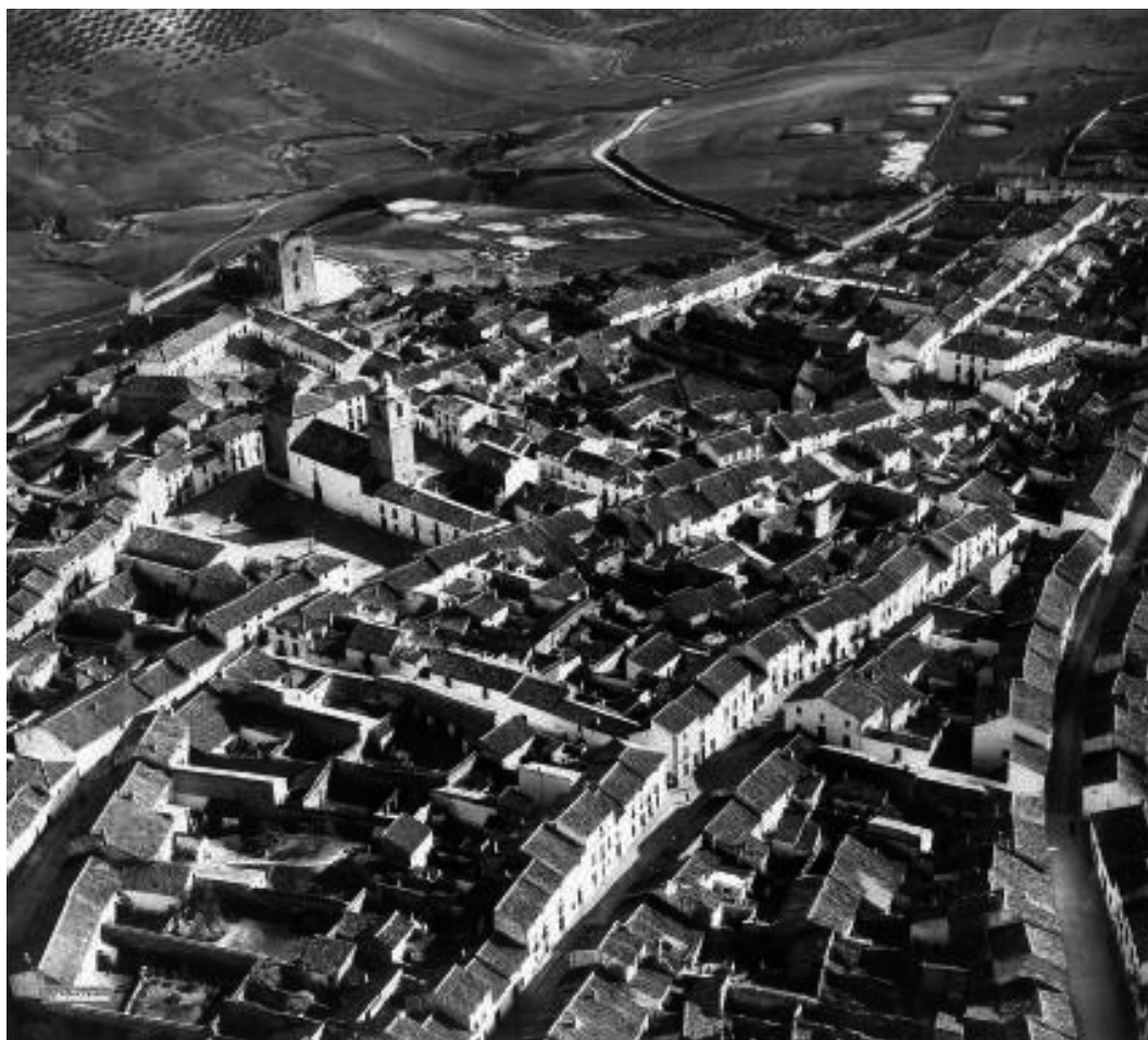
Fotografía aérea cedida por el Excmo. Ayuntamiento de la villa de Villardompardo (Jaén)
