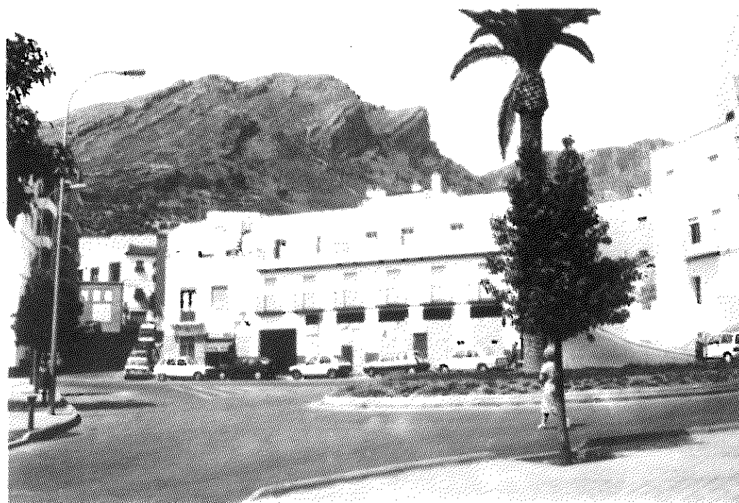
Dos visiones distintas y contrapuestas del Cerro de Almodóvar.
