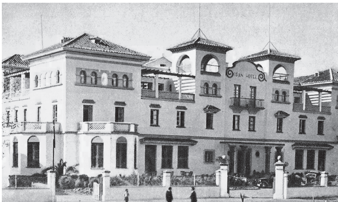
Gran Hotel . La construcción data de los años 20 del pasado siglo. Marmolejo
