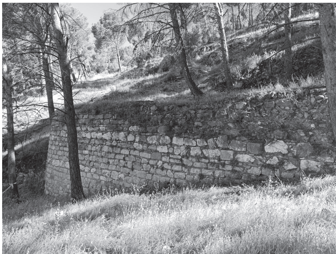
Ilustración 11: Paramento / baluarte defensivo ubicado en la mitad del cerro a modo de cerramiento
