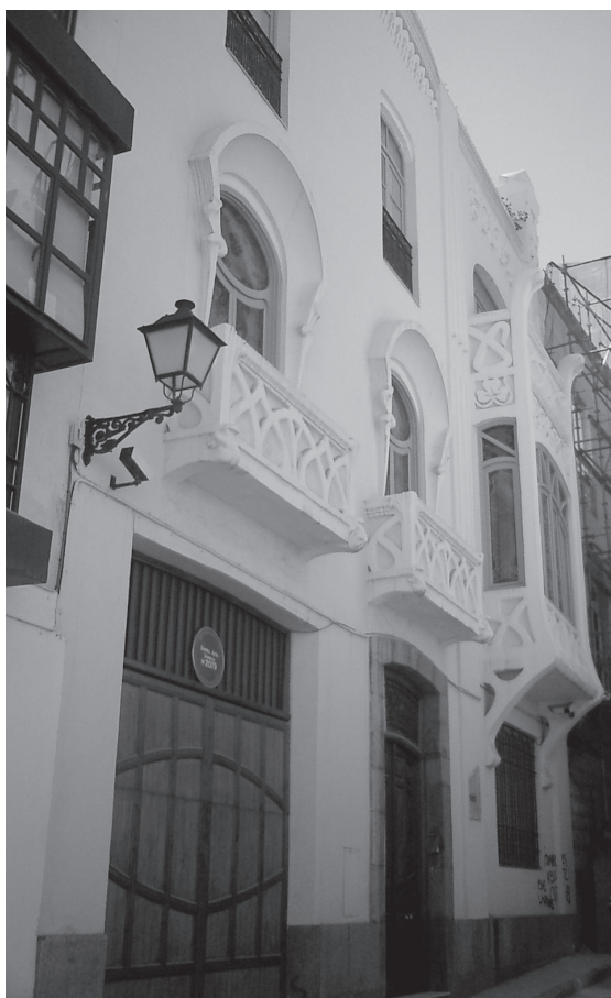
Casa de la calle Hurtado n.º 6 (Antonio Merlo?, 1906-1918)
